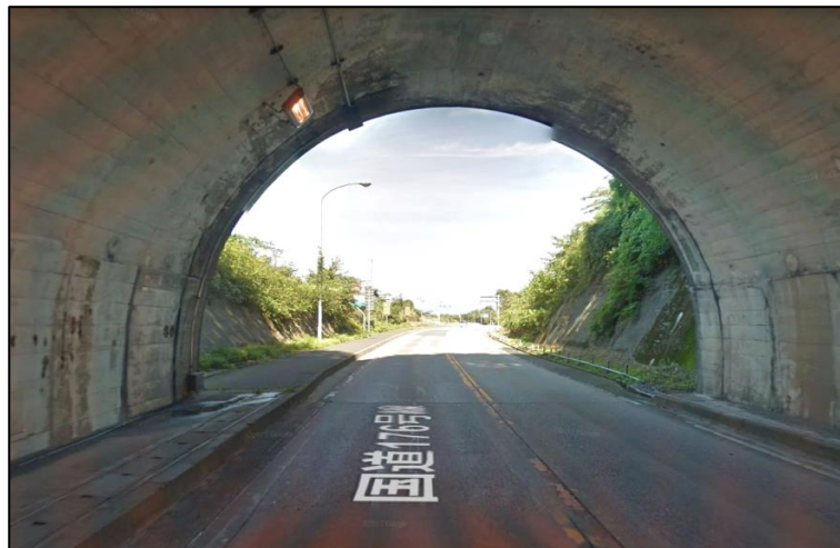
与謝トンネル出口
